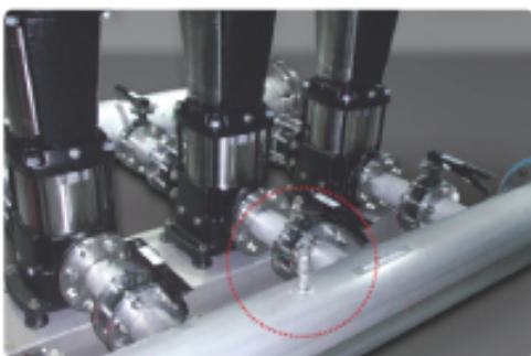
기존 부스터 시스템 ( 토출 압력센서 1개 )
